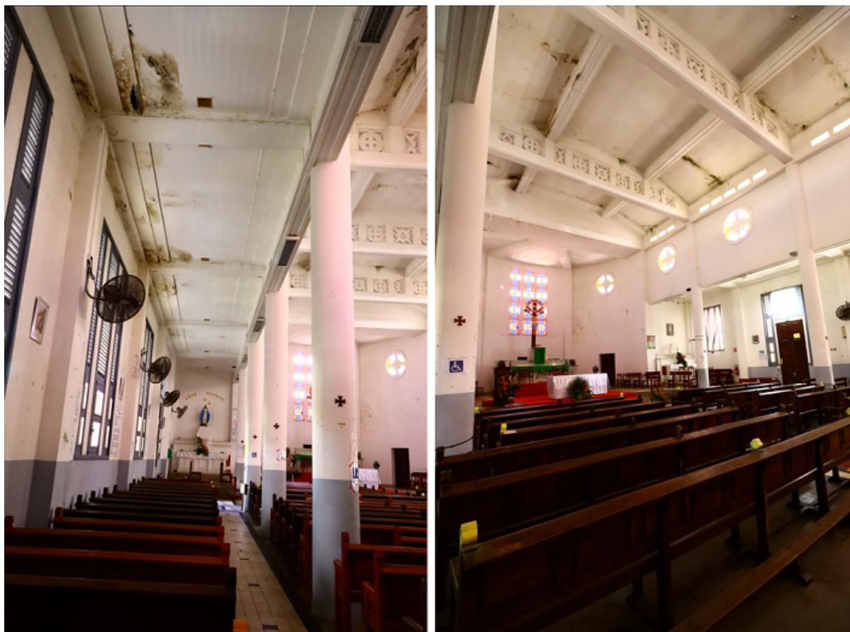
Les dégâts causés par le défaut d'étanchéité de la toiture et des maçonneries se traduisent par des dégradations visibles sur les plafonds, les murs et les faux plafonds à l'église Sainte Trinité à Lamentin. Photo : Ville Lamentin Guadeloupe
