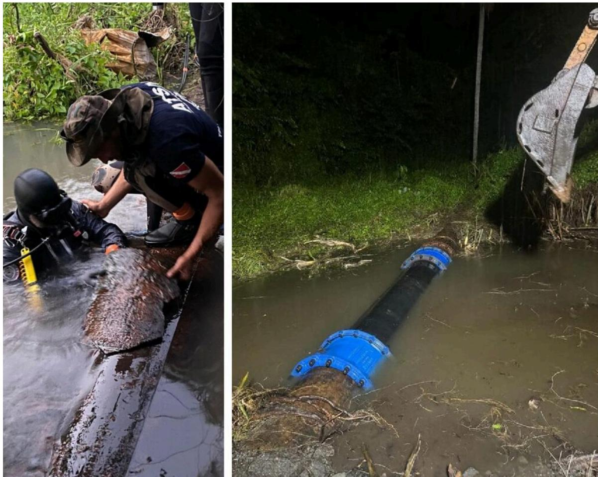
La section endommagée du Feeder a été remplacée par un nouveau segment de quatre mètres, et a été jointe au reste du système à l'aide de deux manchons. Photo : FB Syndicat Mixte de Gestion de l'Eau et de l'Assainissement de Guadeloupe
