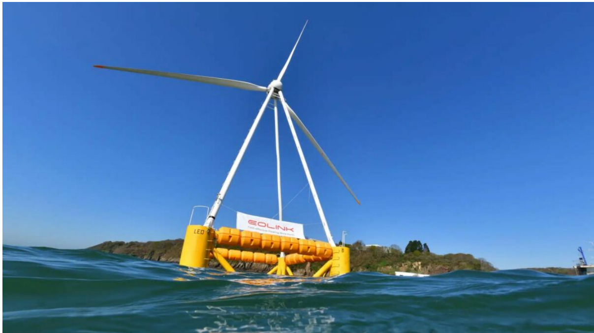
Un prototype d'éolienne flottante en phase de test. Photo : Ifremer-Eolink – O. Dugornay
